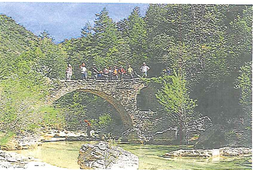
Paso por el puente Yesa, en el camino entre Boltaña y Buerba.
